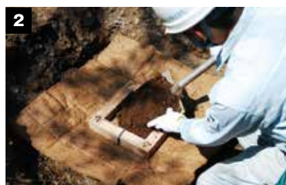
2 根鉢固定台座の内側に、根鉢の位置を調整するための土を入れる。
