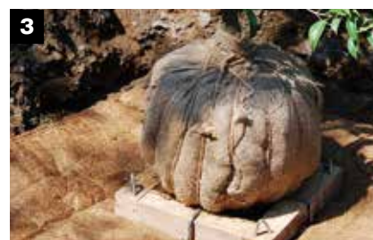
3 根鉢の底にすき間ができないように、土を調整します。
