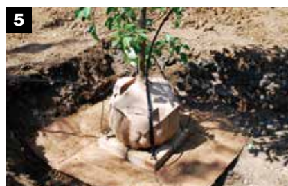
5 結束材を根鉢固定台座のフックから固定シートに通し、しっかりと締める。
