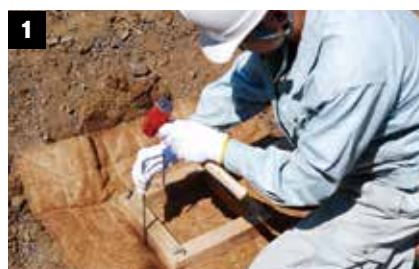
1 植穴に根系誘導底面シートを固定する。
